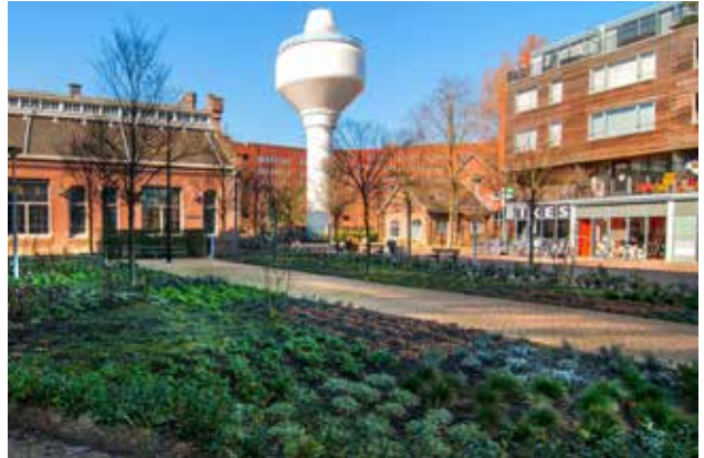
Het Hart: Een gemengd en levendig gebied rondom de bestaande watertoren en reeds aanwezige voorzieningen. Het is een compact bebouwd gebied met openbare en collectieve tuinen die onderling verbonden zijn.
