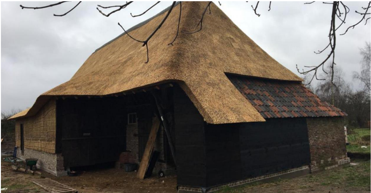
Afbeelding 3, Vlaamse schuur opnieuw opgebouwd (Bron: Zandenbouw BV)
