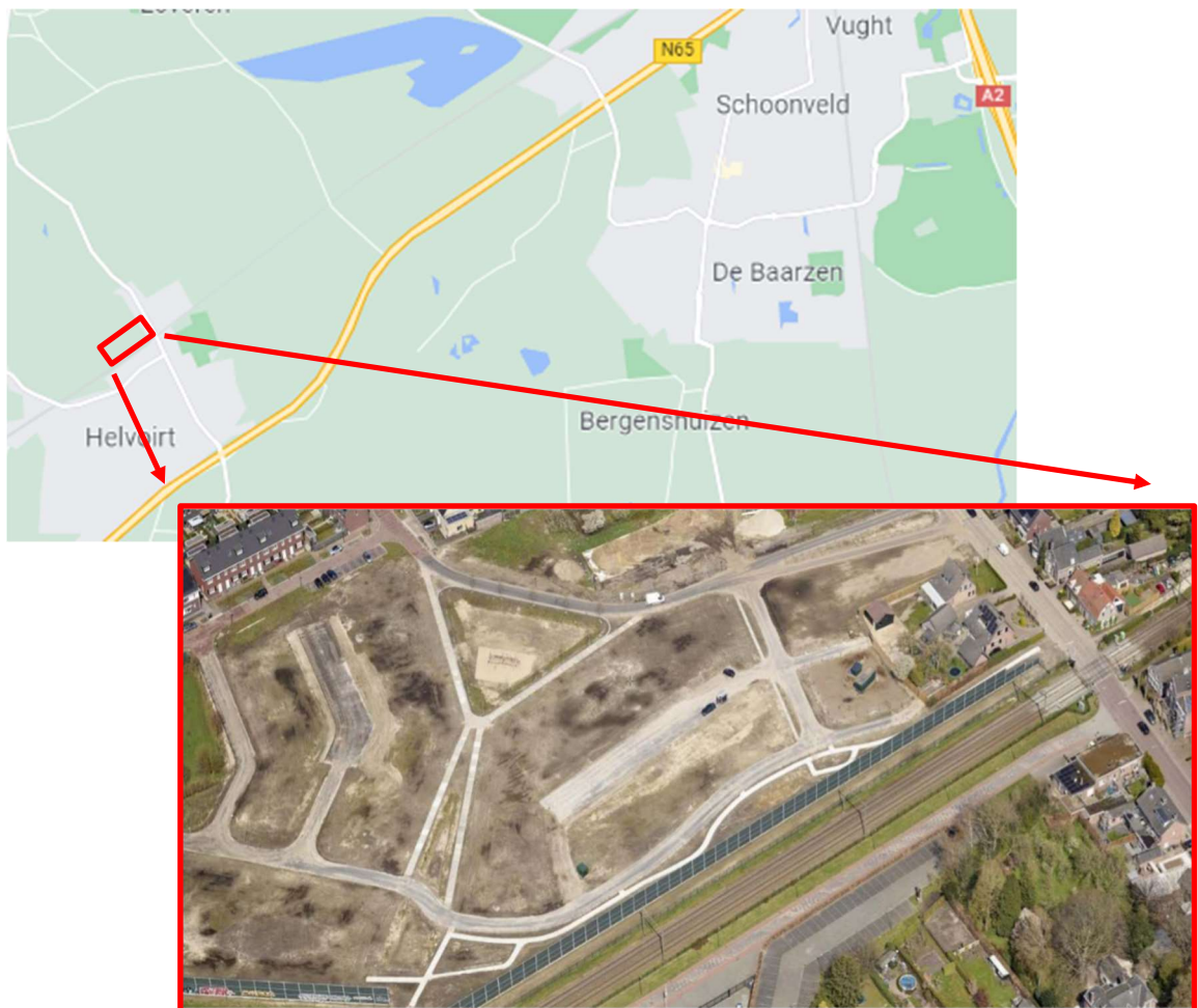
Bouwwijp maken van bouwplan Den Hoek (luchtfoto uit presentatie bewonersavond, 7 juni 2021)
