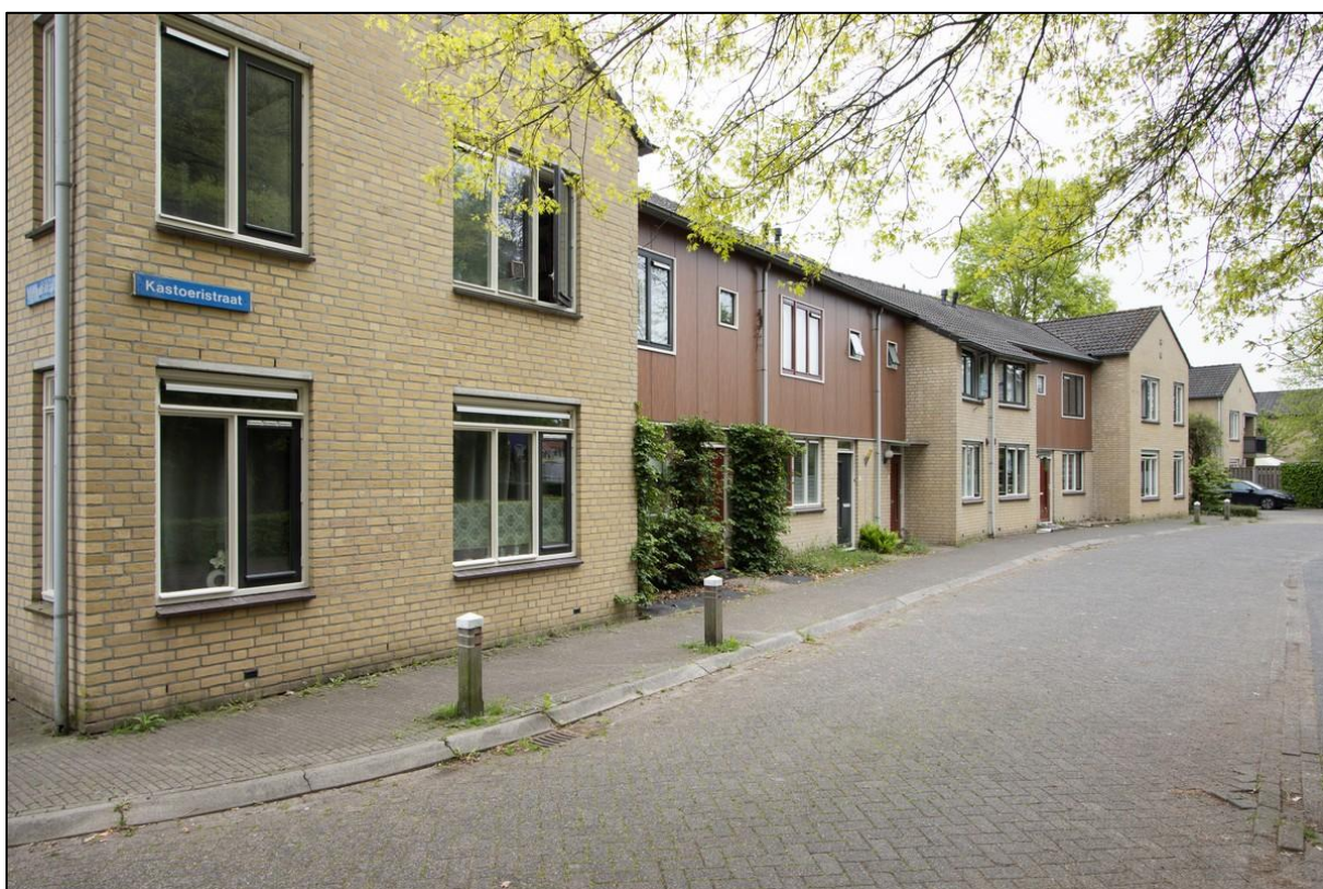
Afb. 4.109 Kastoerisstraat met golvende rooilijn. Hier wel verhoogd trottoir, mogelijk in verband met speelterrein aan de overzijde van de straat.
