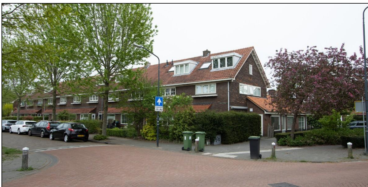
Afb. 4.50 Woning van het type C, op een prominente straathoek en nog herkenbaar de voormalige winkelruimte.
