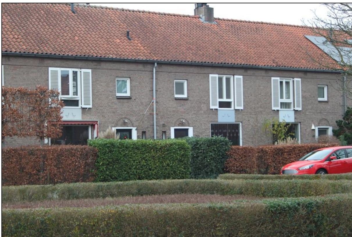
Afb. 4.74 Bij de meeste woningen is het grote venster op de verdieping, met daaronder een gevelornament en voorzien van kenmerkende Louvre-luiken, nog intact.
