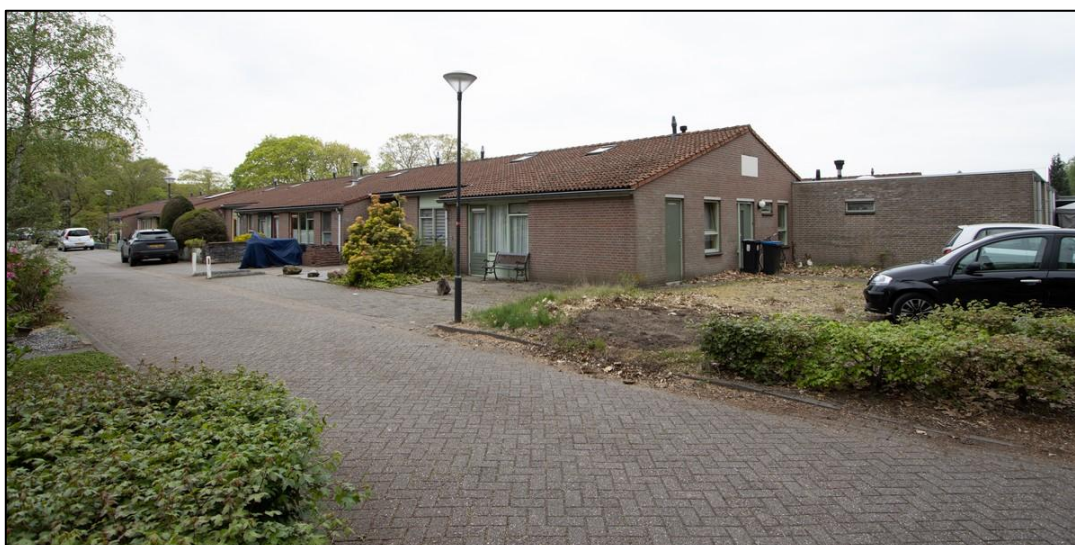
Afb. 4.68 De straatprofielen zijn wat verbreed. Van meet af aan waren in het woonoord klinkerstraten gelegen. In hoofdvorm zijn de huidige woningen duidelijk geënt op de rond 1990 gesloopte barakken.
