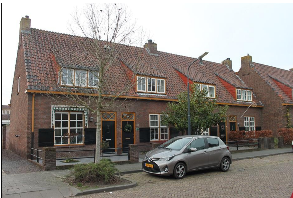
Afb. 4.60 Van Heeswijkstraat, woningtype J, met dakkapellen. De roedeverdeling in de vensters is bij veel woningen nog intact.
