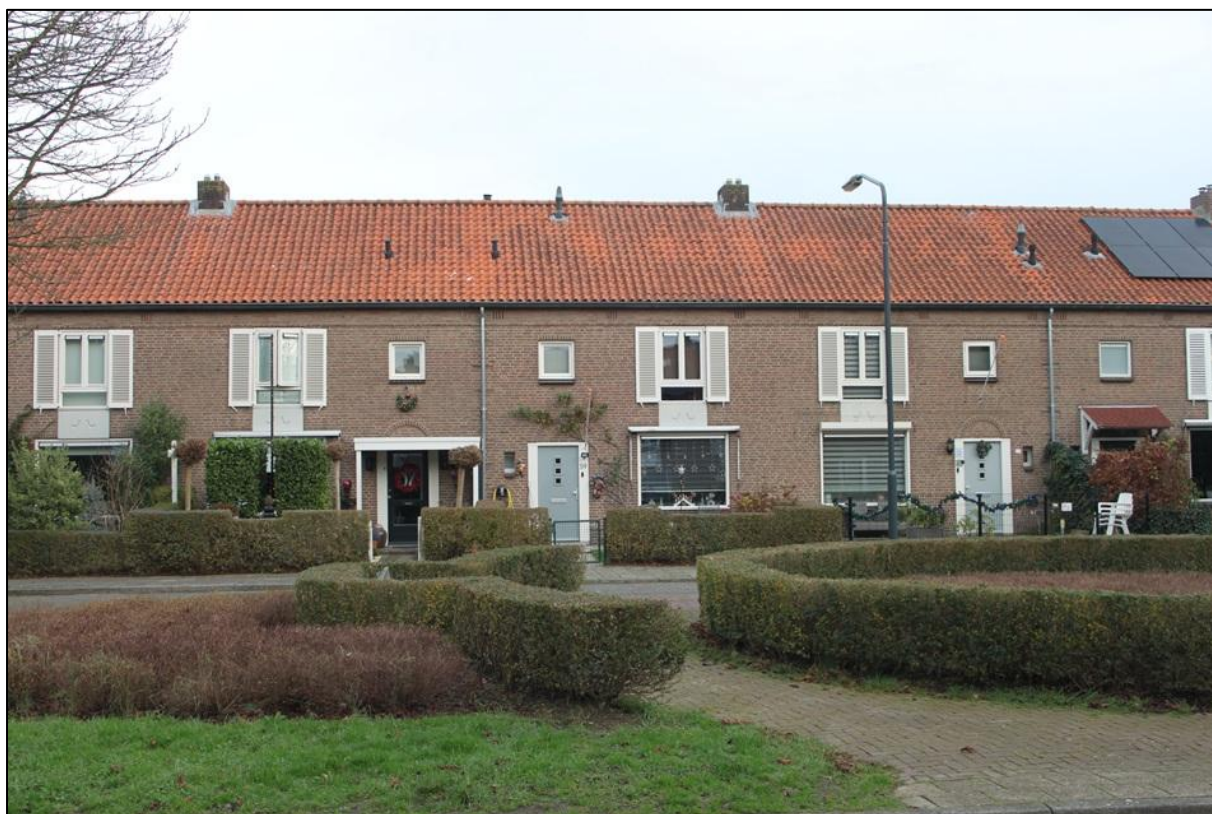
Afb. 4.75 Het oorspronkelijke ontwerp komt minder sterk over door vervanging van de oorspronkelijke deuren en vensters.
