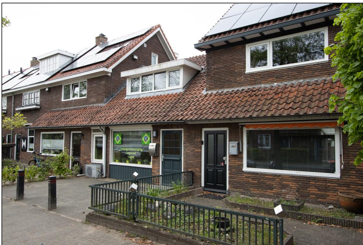
Afb. 4.47 De voormalige werkplaats aan de Esschestraat waarvan de zolder bij de beide flankerende woningen (E1 en E2) was getrokken. De meeste vensters in beeld zijn vernieuwd, net als de voordeuren.
