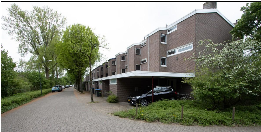
Afb. 4.94 De rondweg langs de spoorbaan, met de woningen van het type X en carports deels nog als zodanig in gebruik. Bij het ontwerp van de buurt zal er geen rekening gehouden zijn met de mogelijkheid dat gezinnen over meer dan één auto zouden gaan beschikken.
