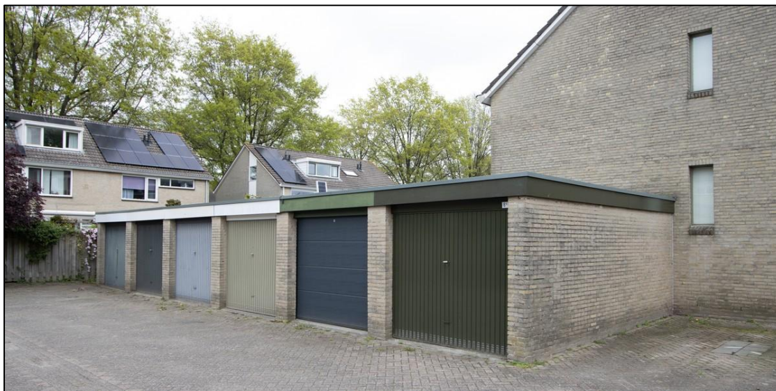
Afb. 4.84 Eén van de vier reeksen garageboxen.
