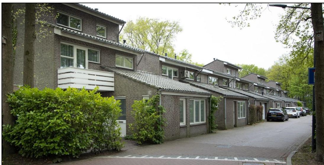
Afb. 4.99 Er is variatie van woningen met één of twee verdiepingen. Op de foto is te zien dat verschillende bewoners hun garage bij het huis hebben getrokken. De ontsluitingsweg met straatklinkers is nooit bestemd geweest om te parkeren. Nu worden auto's langs de gevels van de voormalige garages gezet.
