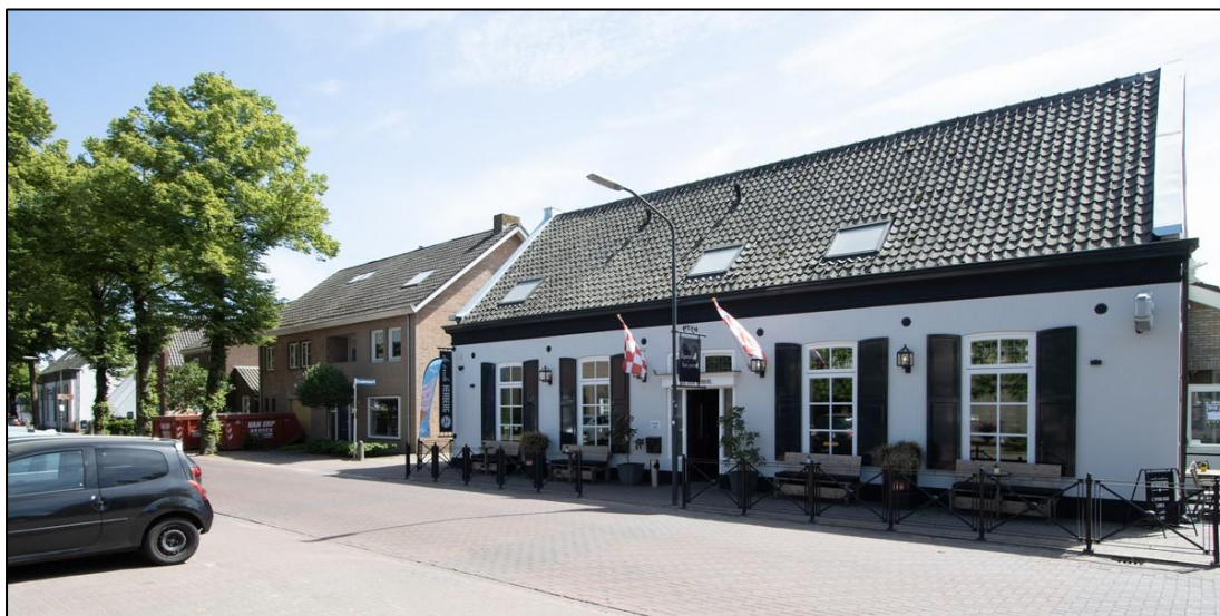
Afb. 4.22 Het verschil in bouwhoogte tussen éénlaags bebouwing uit de 19 e eeuw en latere gebouwen is niet heel groot door reductie van bouwlaaghoogte en flauwere dakhellingen.
